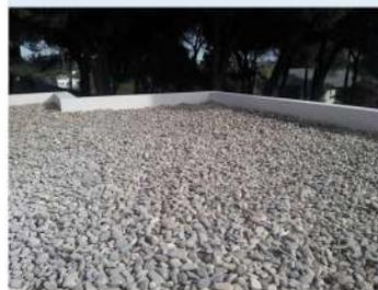
Con impermeabilización de lámina bituminosa de 4kg/m<sup>2</sup>. Con aislamiento térmico XPS de 4 cm y de lana de roca de 9 cm. Acabado en grava.
